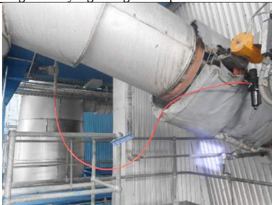
Tubing Plastic sering Lepas pada Actuator Valve
