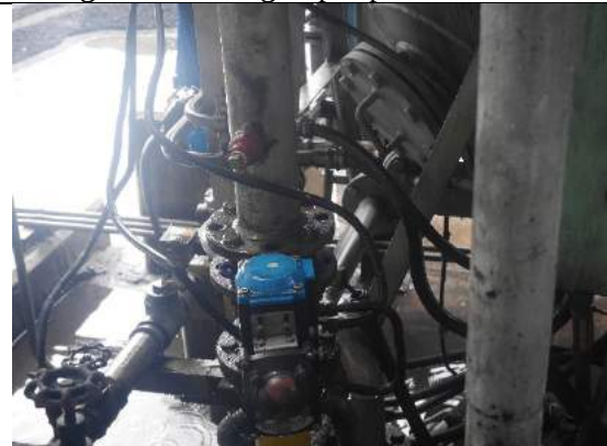
Tubing plastic lepas pada Control Valve
