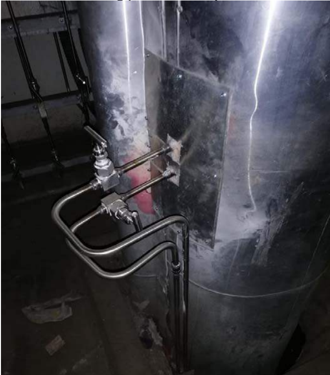
Hasil Welding pada Steam Pipe Main Line
