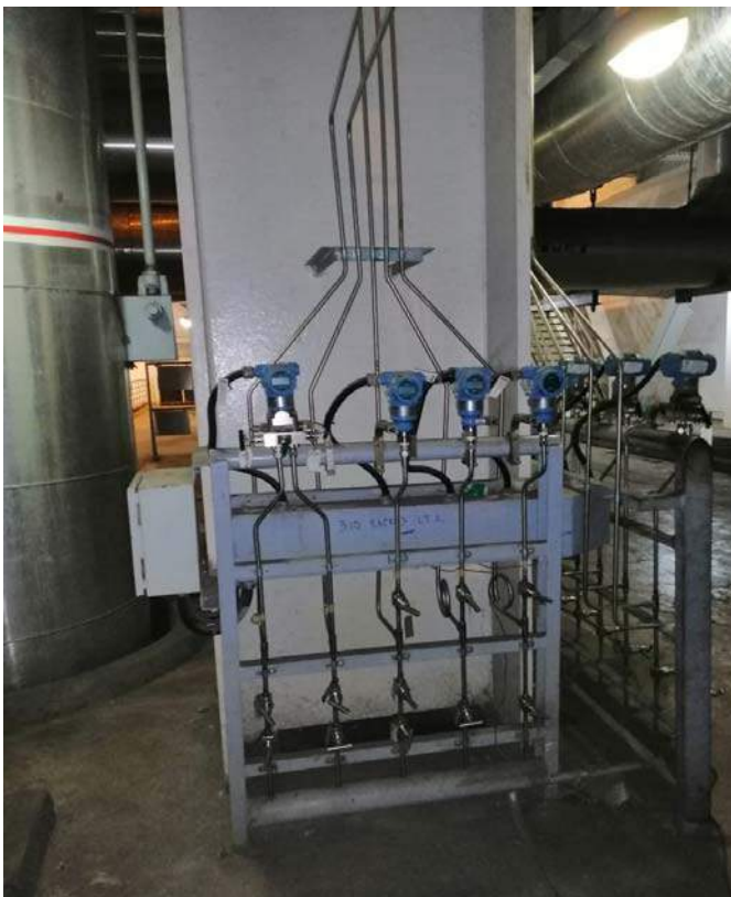
Tubing Installation pada 2-Transmitter Steam dengan terpasang nya Needle Valve Welded steam services
