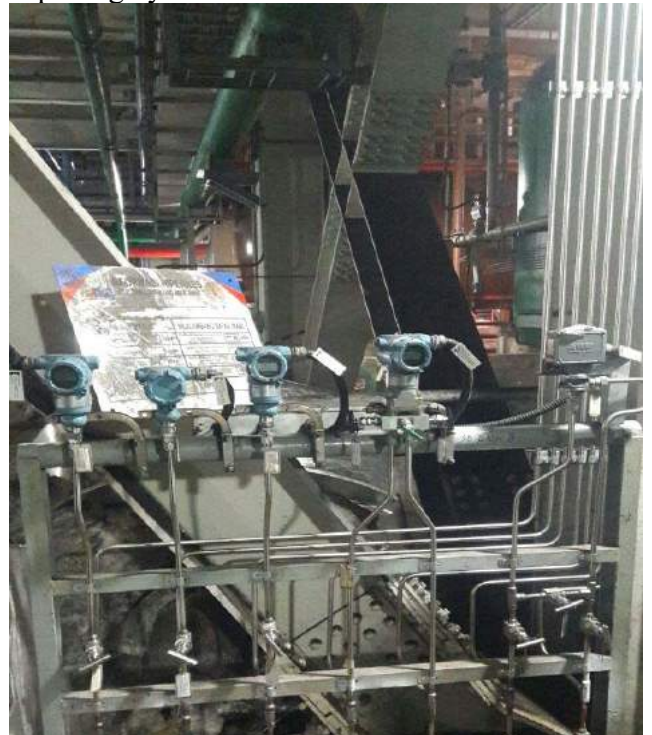
Tubing Installation pada 4-Transmitter Steam dengan terpasang nya Needle Valve Welded steam services
