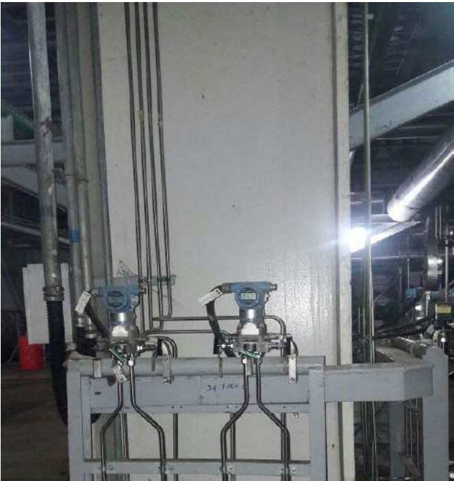
Tubing Installation pada 2-Transmitter Steam dengan terpasang nya Needle Valve Welded steam services
