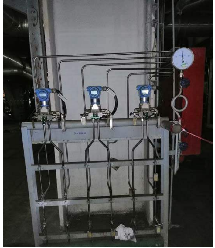
Tubing Installation pada 4-Transmitter Steam dengan terpasang nya Needle Valve Welded steam services
