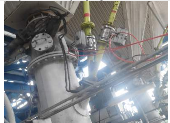
Tubing Plastic sering Lepas pada Actuator
