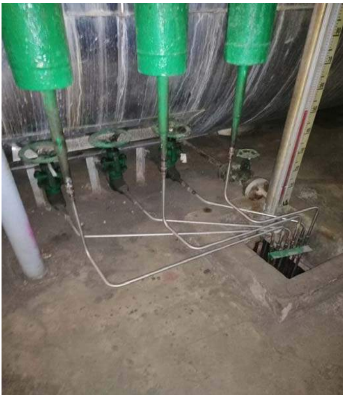
Tubing Terpasang Pada Tapping Point Steam Drum Dengan Welded System
